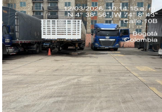
Foto 16. Pisos zona de almacenamiento
