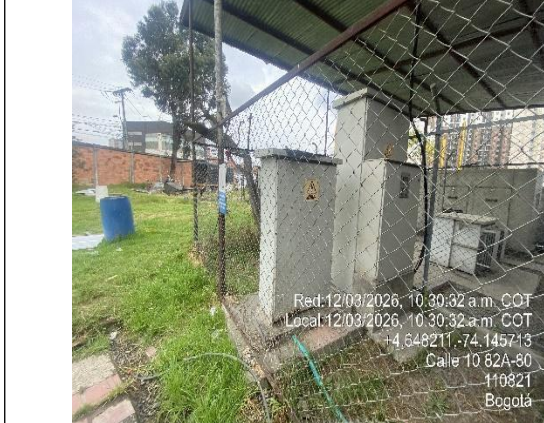
Foto 7. Transformador 150KVA
