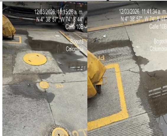
Foto 14. Pisos zona de almacenamiento
